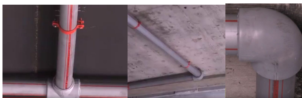
Instalación tuberías plásticas (menor número de accesorios en la instalación)
