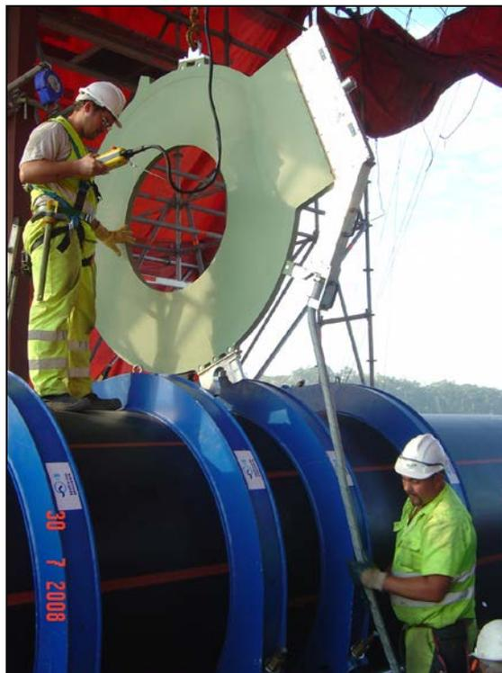
Estos problemas pueden solucionarse utilizando placas recubiertas de PTFE (politetrafluoretileno) y utilizando un dispositivo para retirar la placa rápidamente. Las nuevas generaciones de máquinas de soldar a tope disponen de sistemas que retiran la placa rápidamente
