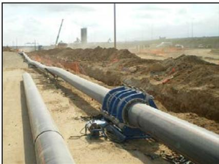
Fig. 3.1 Máquina de soldar a tope de obra
