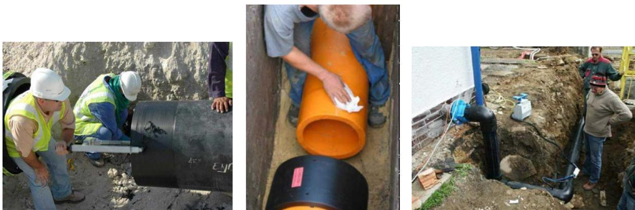
Fig. 2.11 Algunas obras realizadas con accesorios electrosoldables
