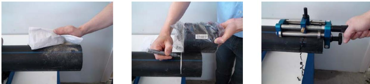
Fig. 2.5 Limpiar, marcar y raspar
