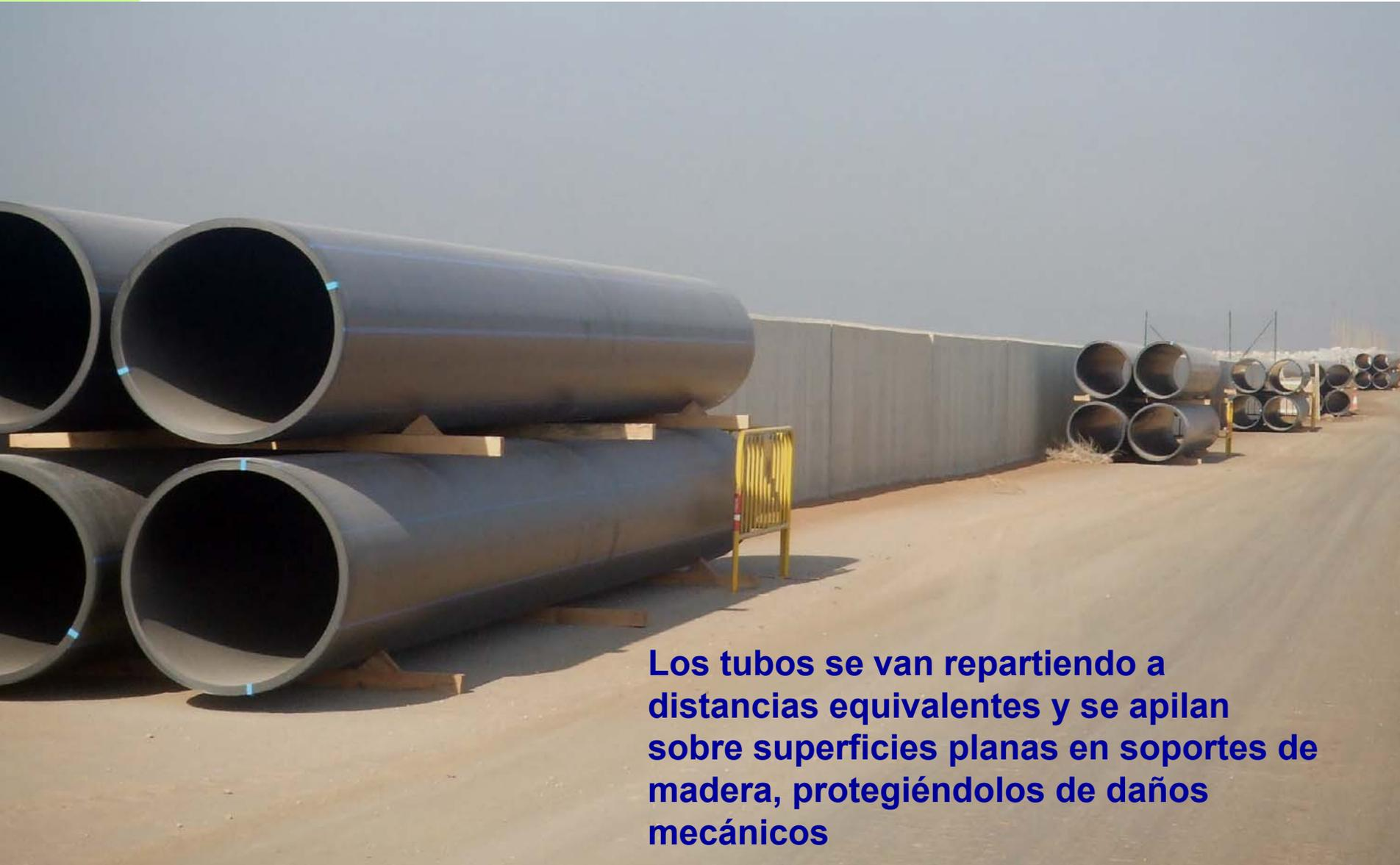
**Los tubos se van repartiendo a distancias equivalentes y se apilan sobre superficies planas en soportes de madera, protegiéndolos de daños mecánicos**
