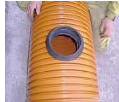
**3.** Introduzca el clip elastomérico haciendo coincidir las flechas de la goma con el eje longitudinal del tubo.
