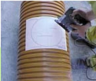
**1.** Corte por el trazo de la plantilla usando una máquina de calar mecánica o manual.
