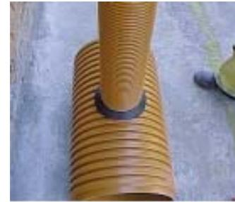
**4.** Utilizar lubricante para insertar el tubo de acometida
